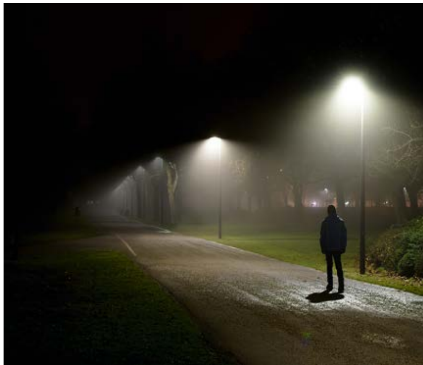
Ob Fussgänger oder Auto: Eine angepasste Strassenbeleuchtung spart Energie.
