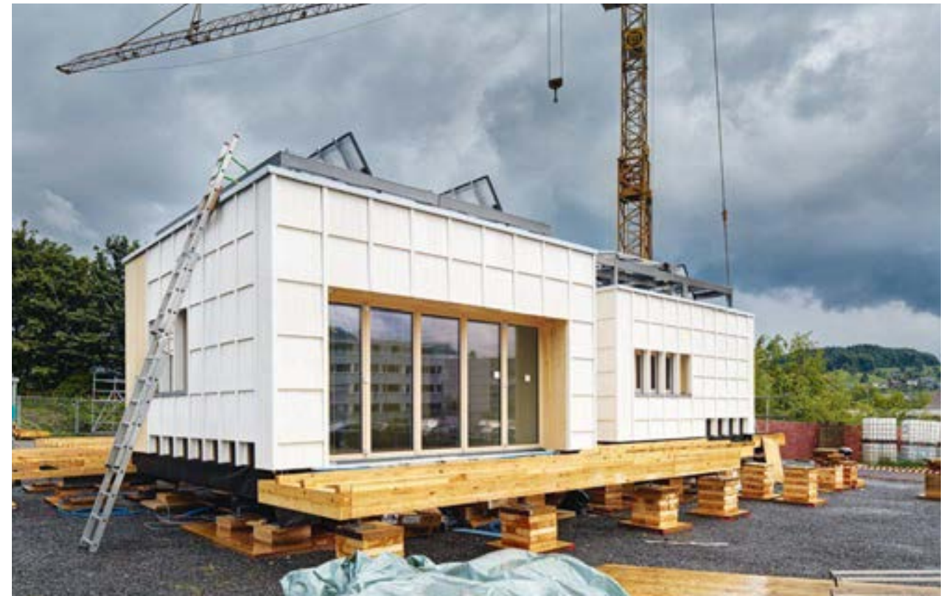
Stand der Bauarbeiten in Horw Mitte Mai.
