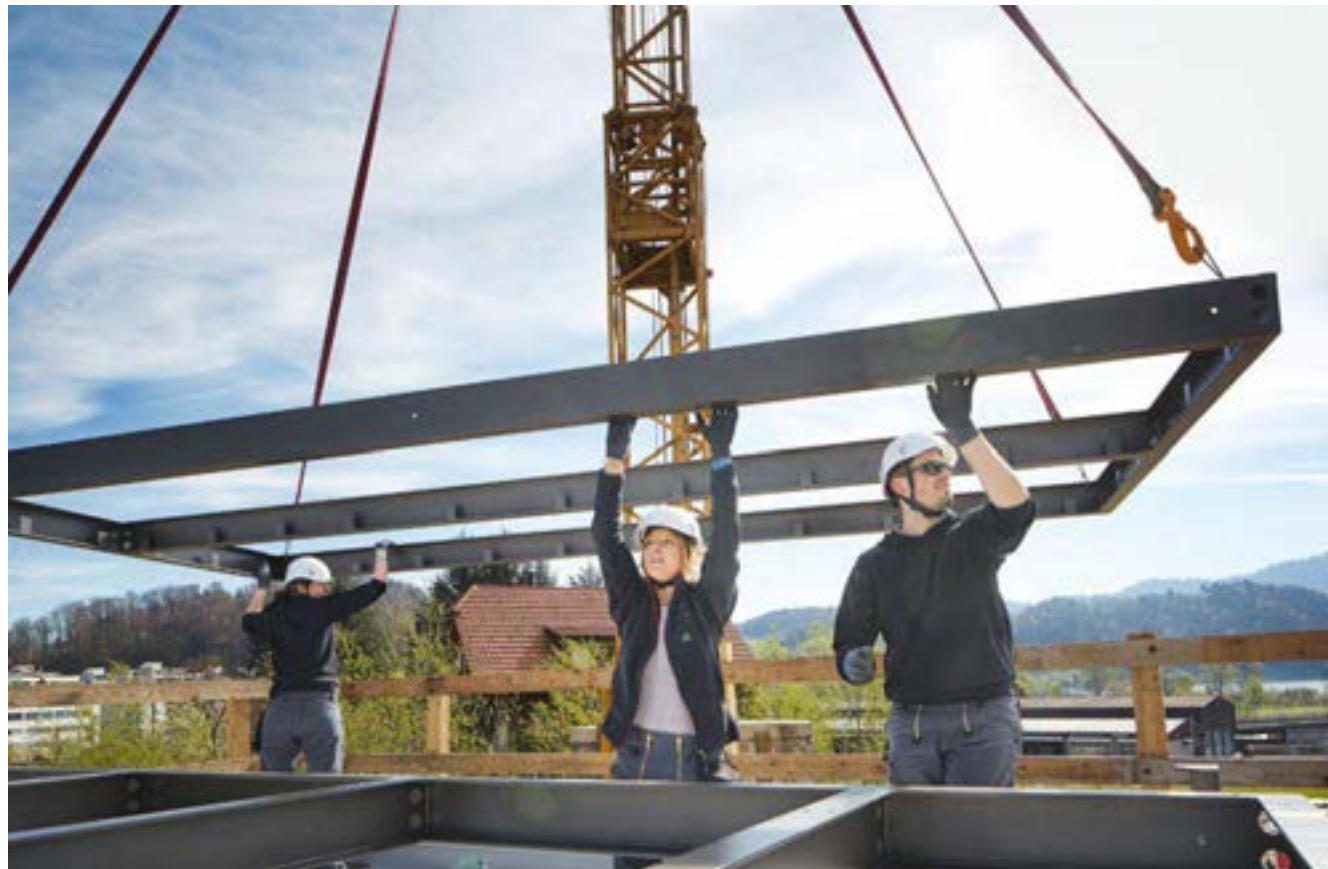
Die Dachelemente müssen punktgenau platziert werden.
