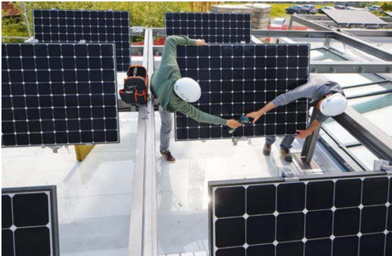
Montage der Fotovoltaikpanels auf dem Dach des Gebäudes.
