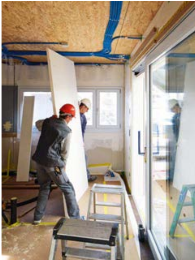
Wände werden eingebaut.
