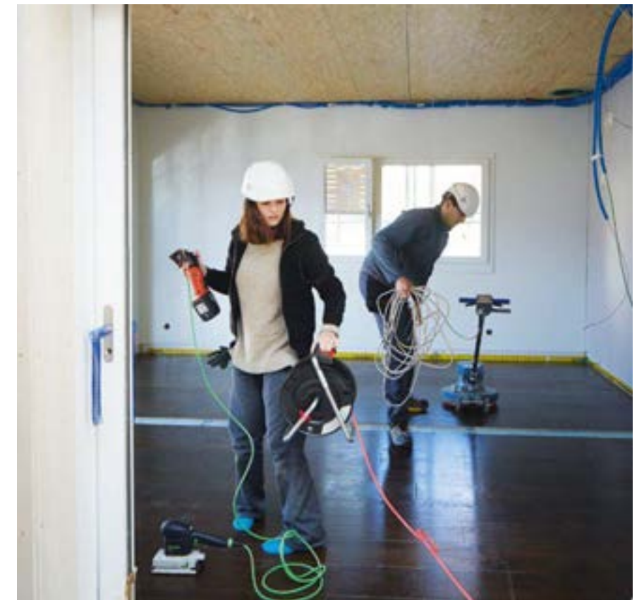
Beim Innenausbau: Die Böden bekommen den letzten Schliff.
