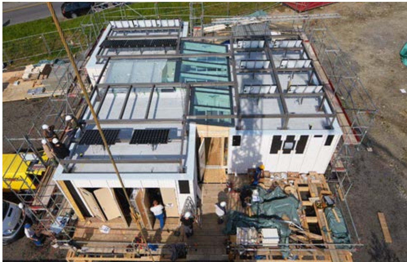
Stand der Bauarbeiten auf dem Campus der Hochschule Luzern – Technik & Architektur in Horw Mitte April.
