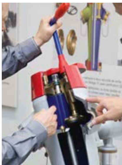
Hydrophone in Hydranten erkennen, wenn ein Leck die Geräuschkulisse im Leitungsnetz verändert.
