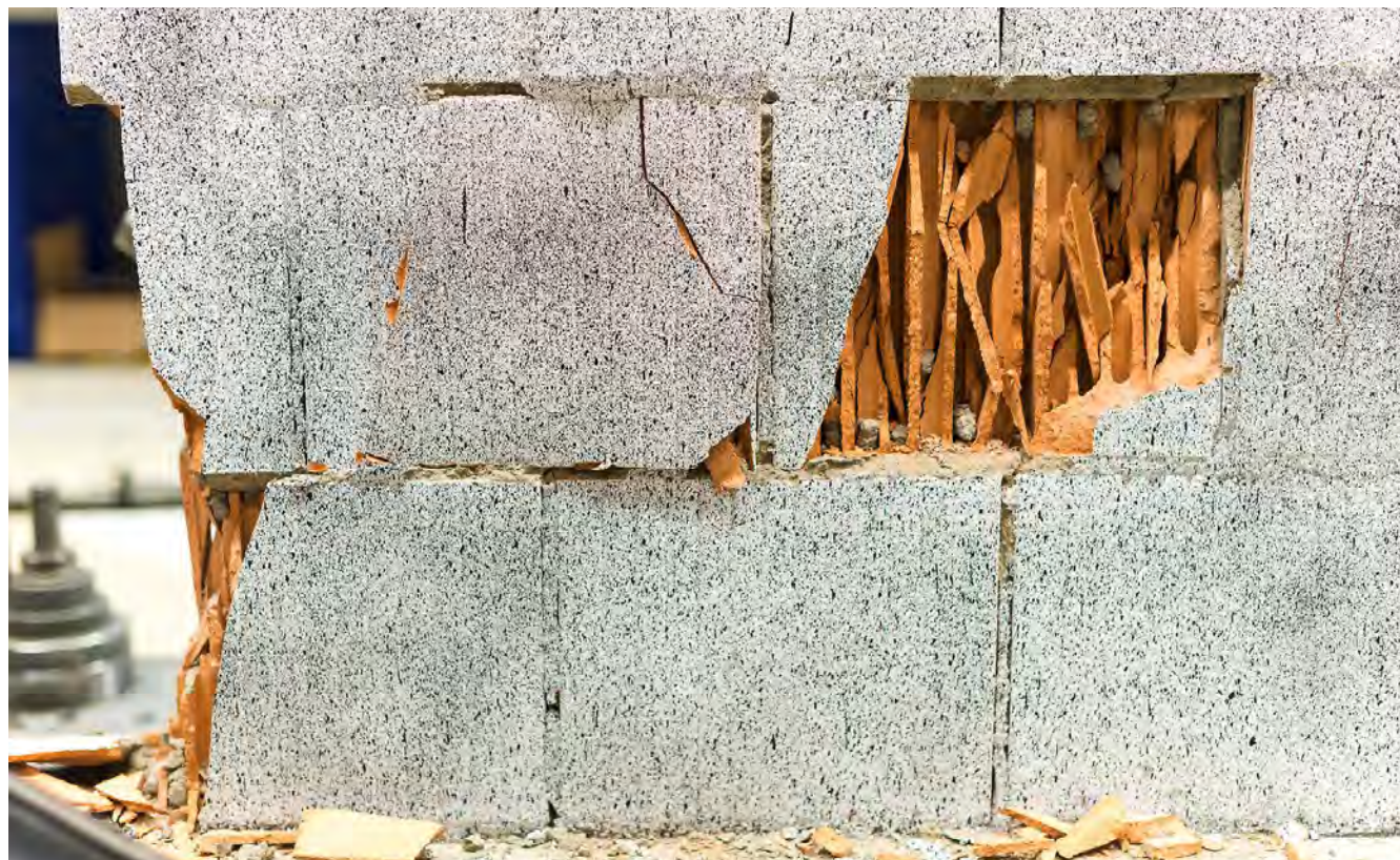
Vom kleinsten Riss bis zur zerstörten Fassade: Die Auswirkung von Erschütterungen auf Baumaterialien wird akribisch dokumentiert.
