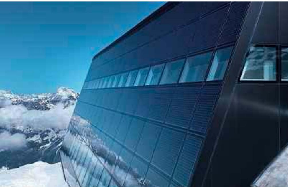
Photovoltaik-Fassade auf fast 4000 Metern Höhe: das «Solar Restaurant Klein Matterhorn».
