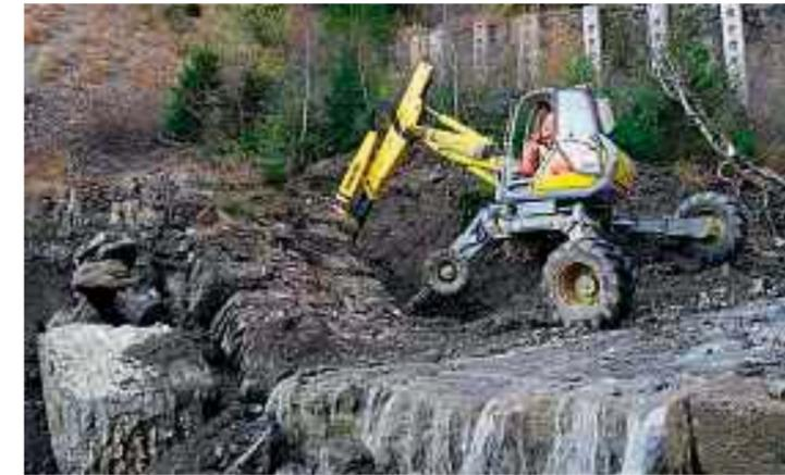
Um die Rückseite der Sperren zu untersuchen, mussten sie mit Hilfe eines Baggers freigelegt werden.
