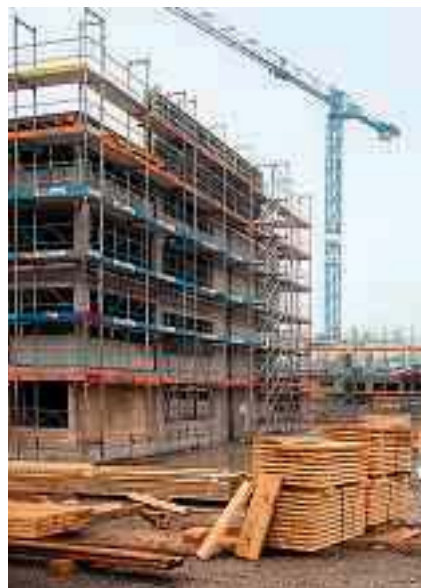
Blick auf die Baustelle in Rotkreuz.
